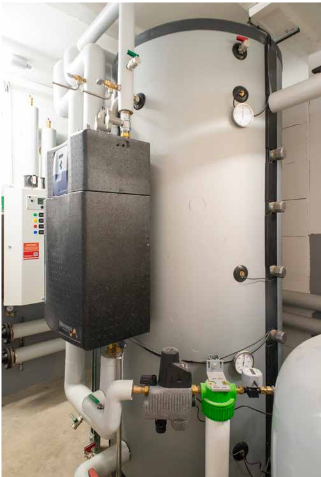
Einbau einer zentralen Heizungs- und Warmwasseranlage im Quartier
