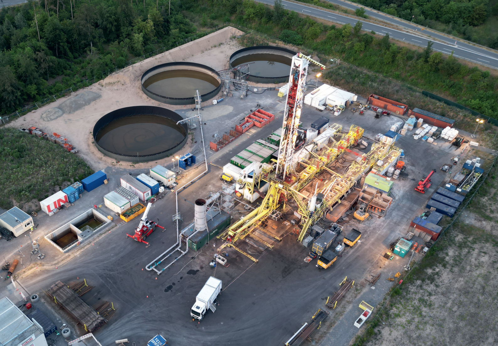
Geothermiebohranlage der Deutschen Erdwärme in Graben-Neudorf.
