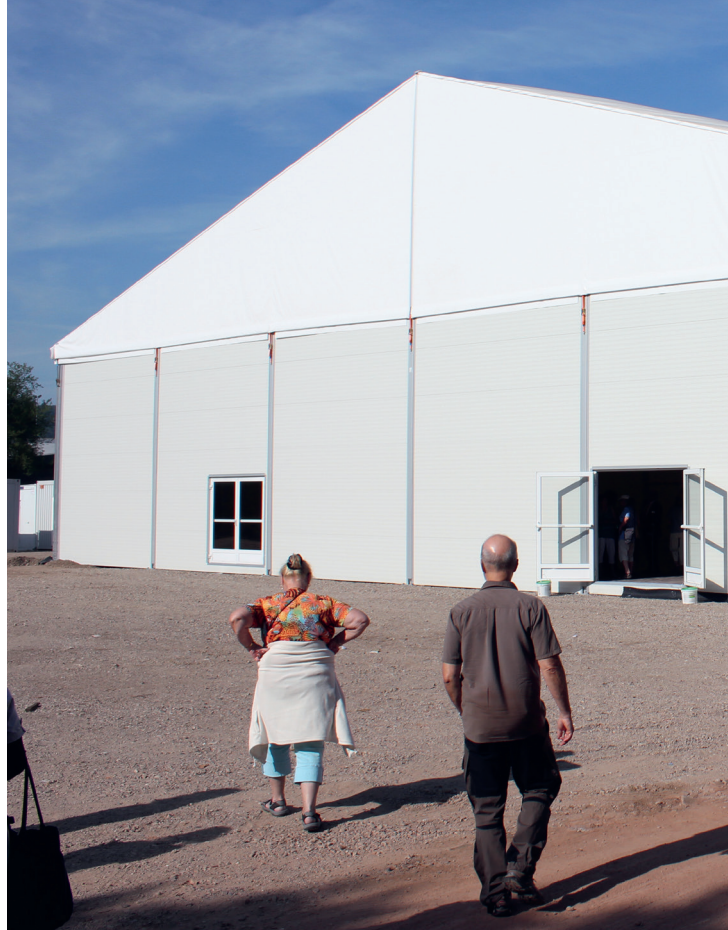
Um den Geflüchteten schnell eine Bleibe zu verschaffen, wurden 2015 drei Leichtbauhallen errichtet.
